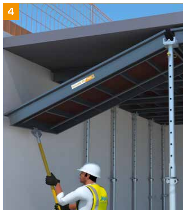
4 - Retirer le panneau grâce à la perche HorizontAL.
