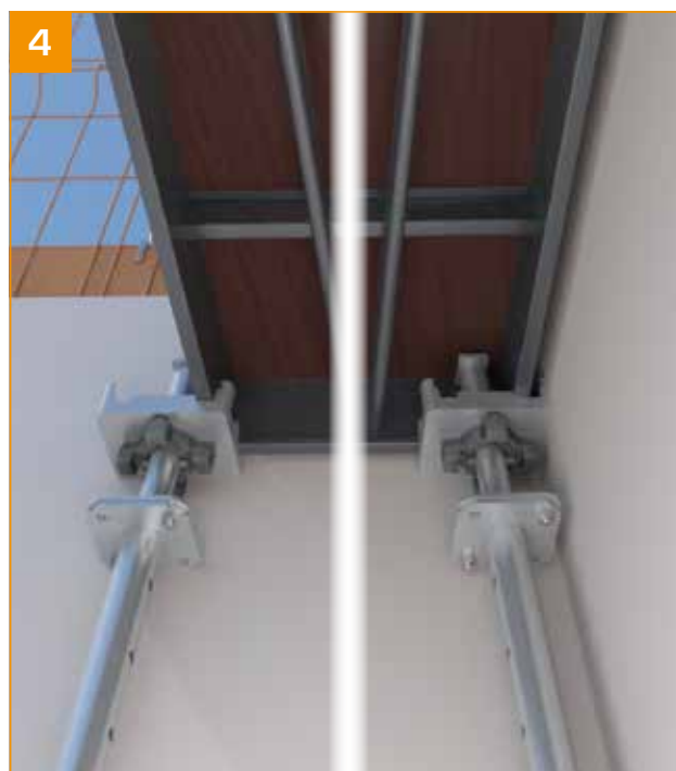
- L'étais dans l'angle de la cellule doit être parfaitement plaqué au voile.
