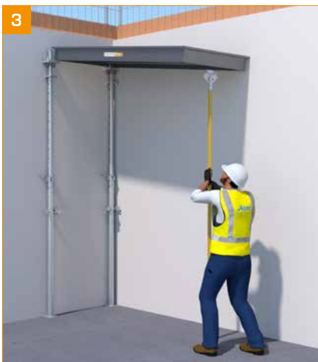
- Relever le panneau à l'aide de la perche HorizontalAL.
