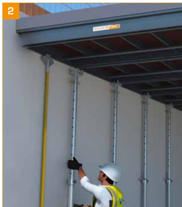
2 - Procéder au retrait des étais contre le voile pour basculer le panneau.
