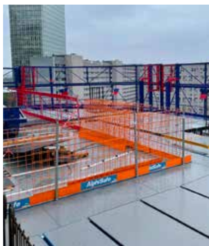
Sécurisation intermédiaire permettant de poursuivre la mise en place du coffrage
