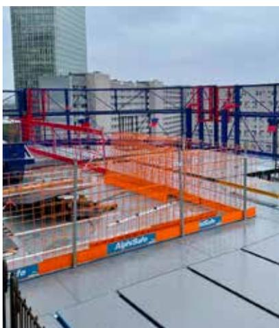
*Proteção intermédia que permite prosseguir com a colocação da cofragem*
