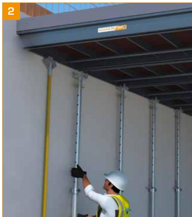
2 - Proceder à remoção das escoras contra a parede para libertar o painel.
