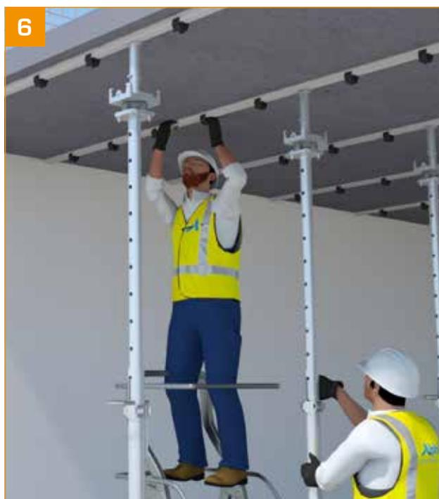
6 - Após a secagem, remover as juntas e as escoras.
