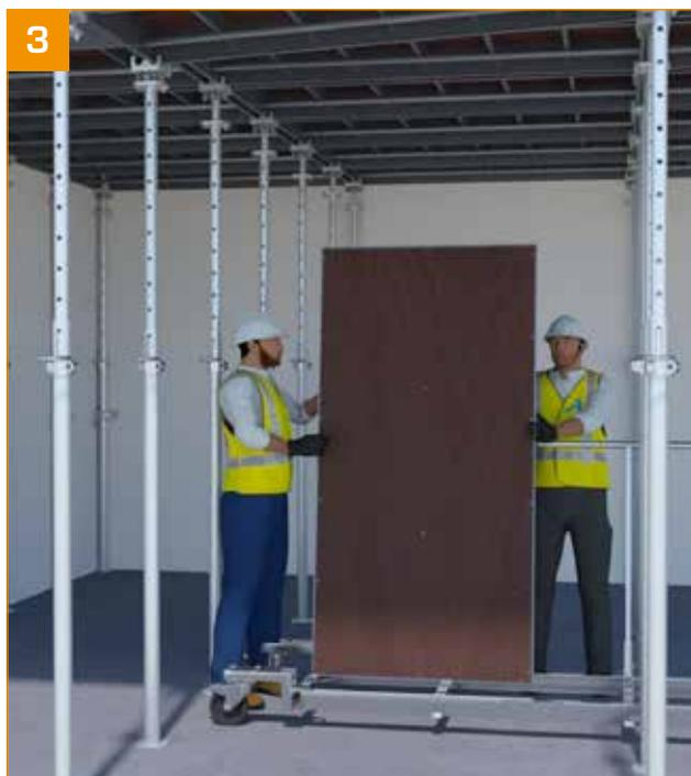
3 - Armazenar os painéis na base móvel para movê-los sem esforço até à célula seguinte.
