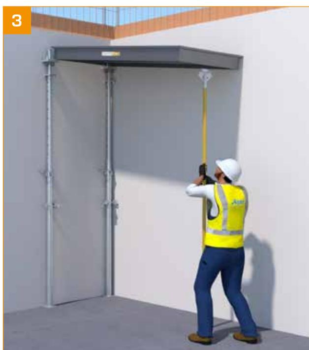
3 - Levantar o painel utilizando a sonda HorizontalAL.
