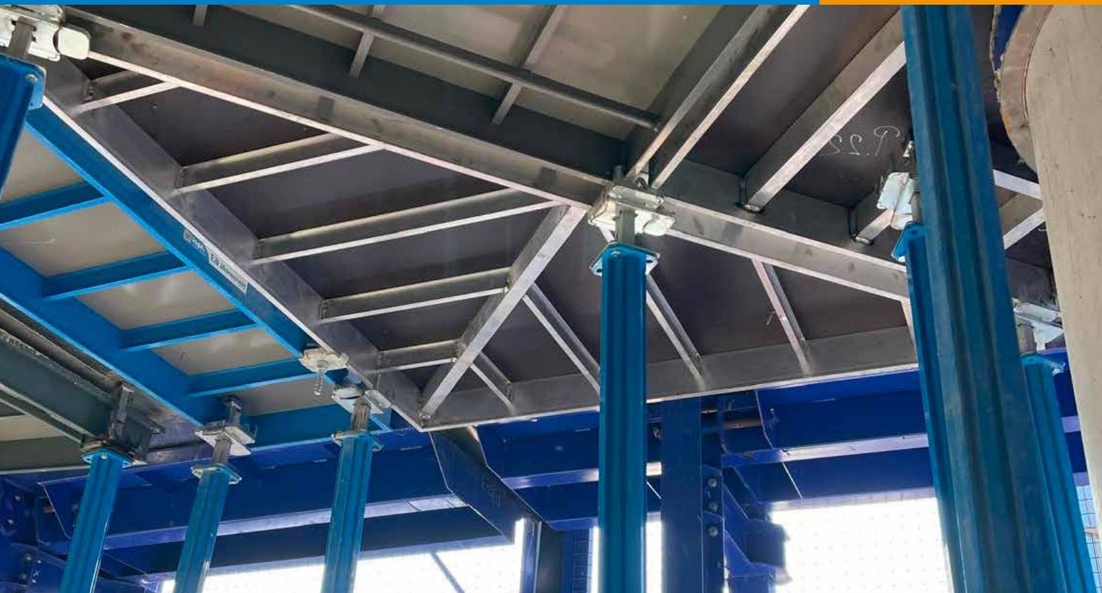
A gama HorizontAL é uma cofragem em painéis destinada às grandes células, sendo particularmente adequada para a construção de edifícios funcionais. Uma cabeça de escora única simplifica a montagem.
