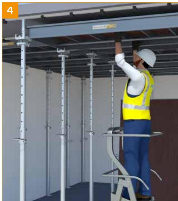
4 - Para o resto da célula, descofrar as cabeças de descofragem rápida.
