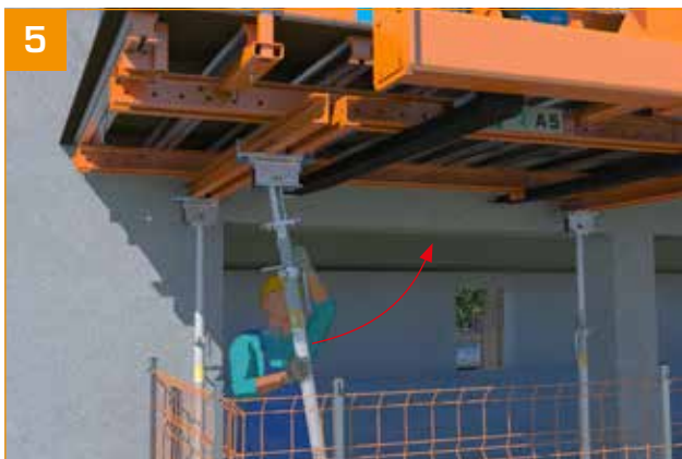
5 - Remonter le fût de l'étais. - Le verrouiller en position fermée. - Basculer l'étais en position inclinée. - Répéter l'opération pour chaque étais.
