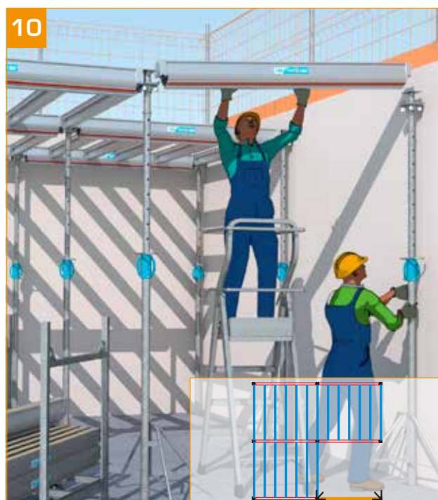
- Mise en place d'une nouvelle poutrelle primaire sur ST.
