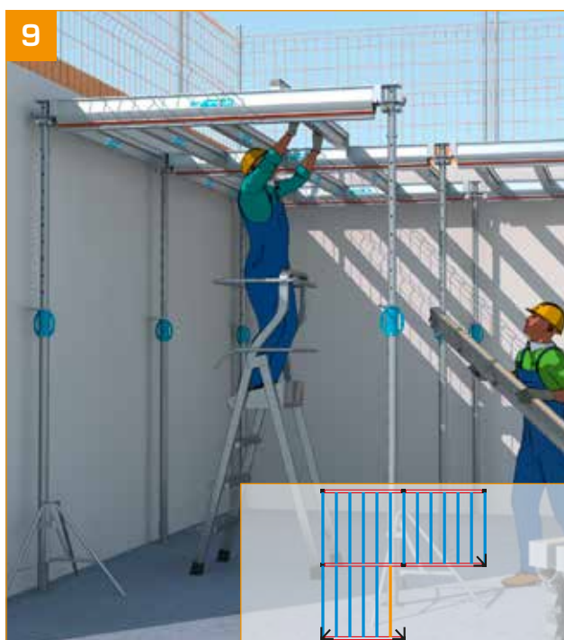
- Avancer les poutrelles secondaires de proche en proche.
