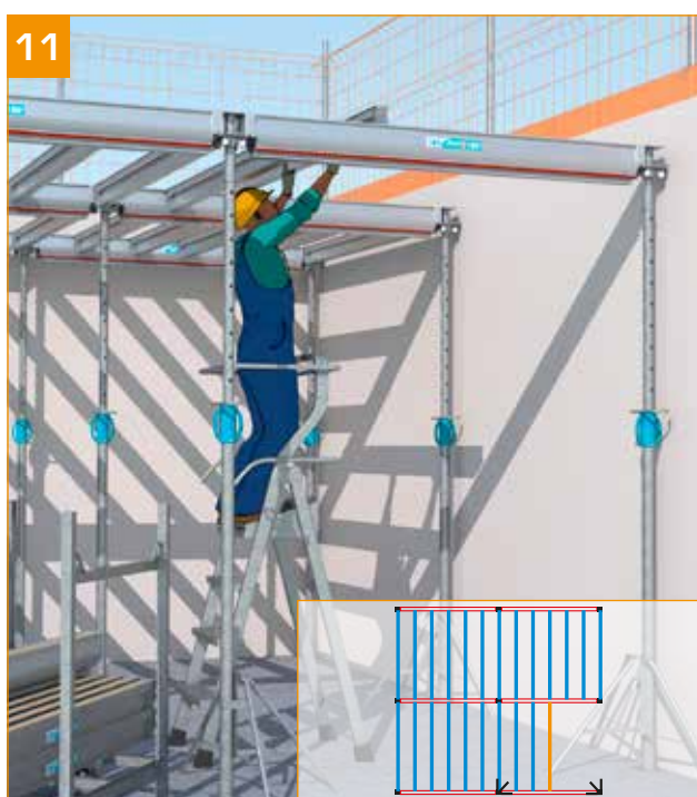
- Avancer les poutrelles secondaires de proche en proche en respectant le vide de 39 cm.
