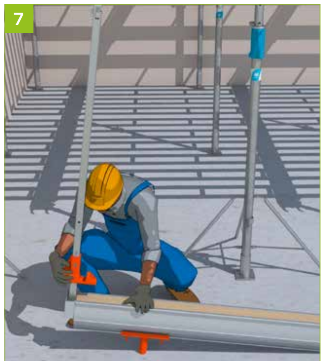
7 - Montar o adaptador AlphiSafe para vigota primária, com o respetivo prumo AlphiSafe. O dispositivo contra desenganche acidental prende-se automaticamente.
