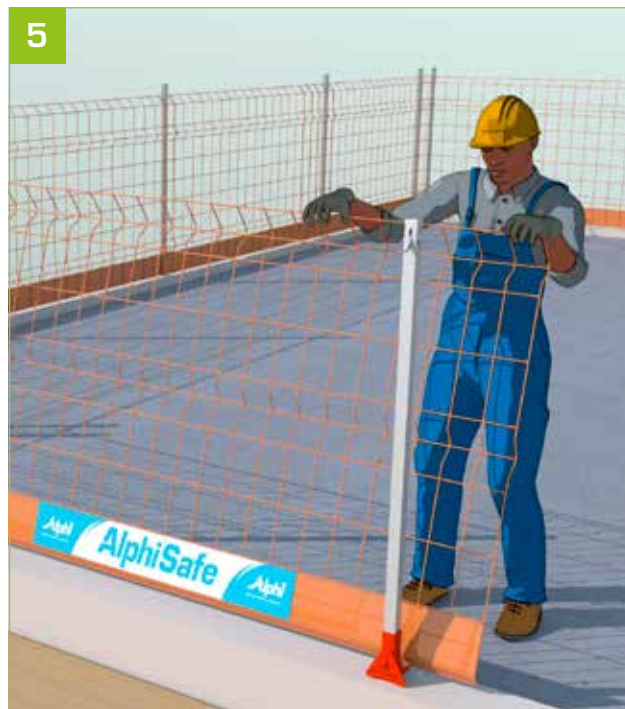
- Posicionar a rede, certificando-se de que o rodapé está bem inserido no encaixe inferior do adaptador e a parte superior na abertura existente.
