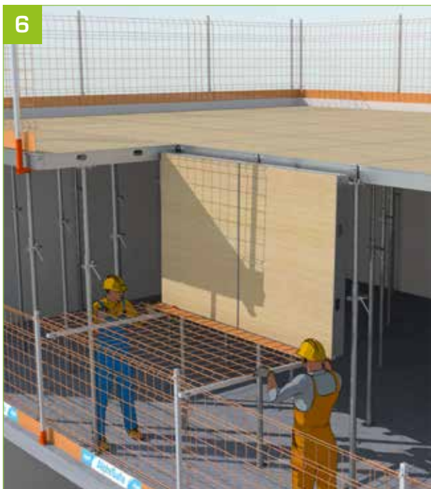
- Posicionar a rede AlphaSafe.
