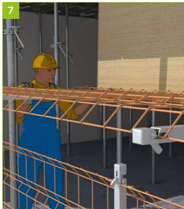
- Garantir que a rede fica bem posicionada nos encaixes superior e inferior dos prumos.
