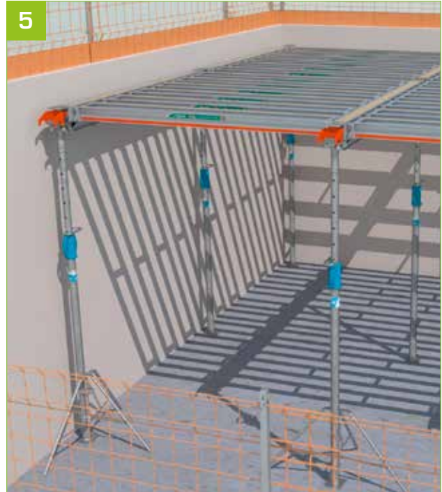
5 - Completar os conjuntos de vigotas secundárias com a ajuda da vara TopPerche.
