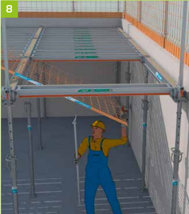
8 - Instalar a rede AlphiSafe com menos de 15 kg, deslizando-a sobre a cofragem, com o rodapé do lado dos prumos e o autocolante virado para cima.
