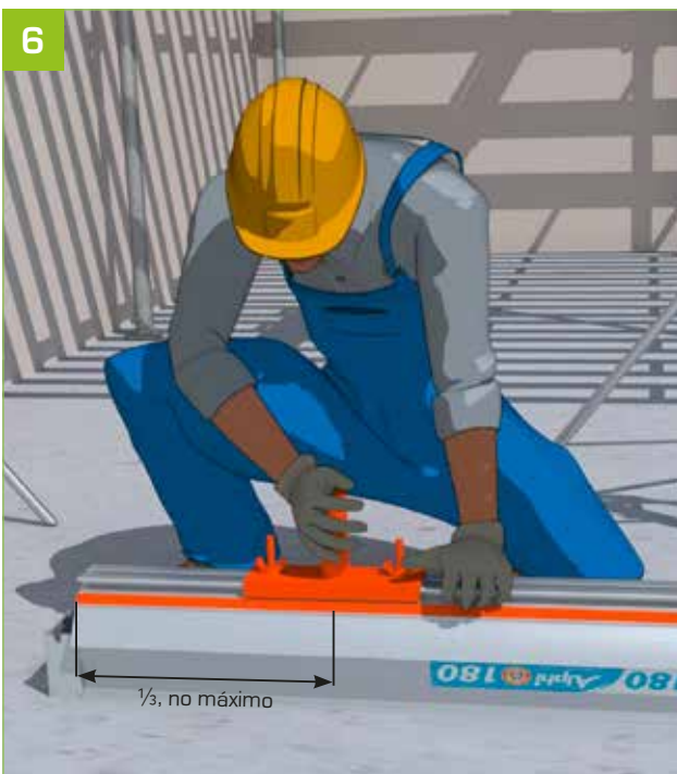
6 - Montar a forquilha de segurança antibasculamento (FSAB) na vigota primária em consola, sem ultrapassar a regra de \frac{1}{3} - \frac{2}{3} relativamente à dimensão da vigota.
