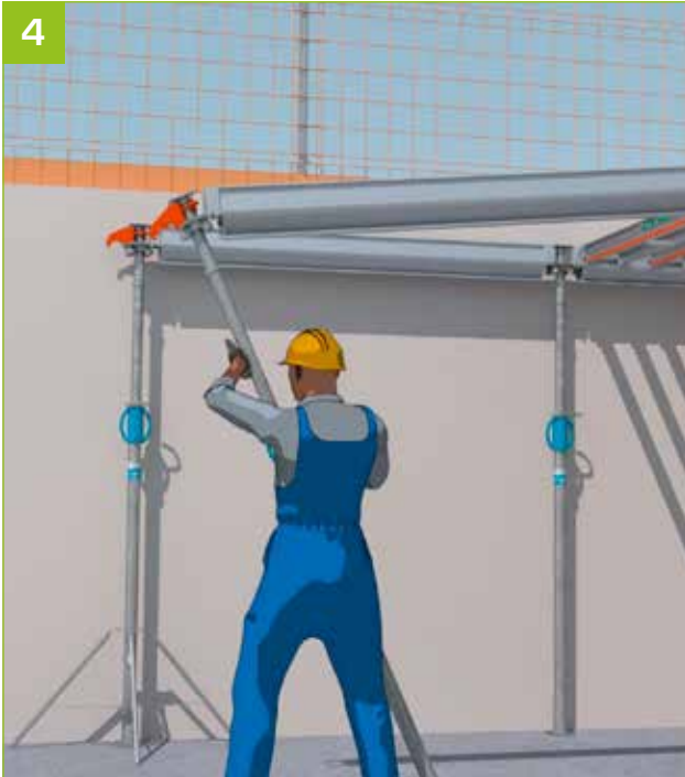
4 - Prosseguir com a montagem da vigota primária sobre a escora traseira, posicionar a escora com o ligador na extremidade da vigota primária.
