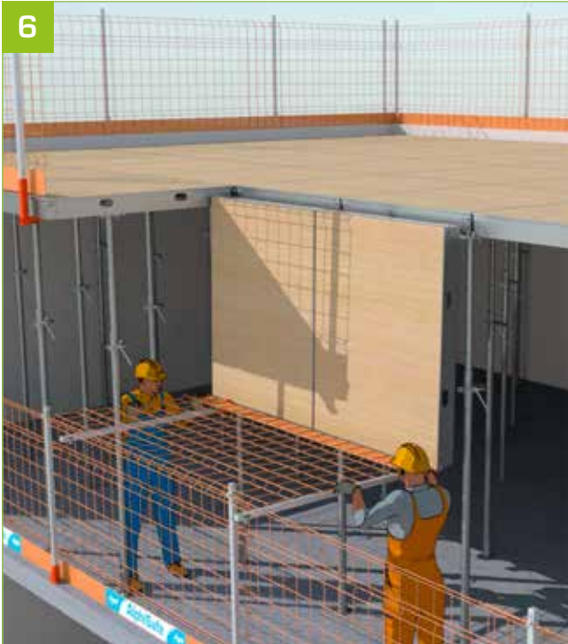
- Das AlphiSafe-Gitter anbringen.
