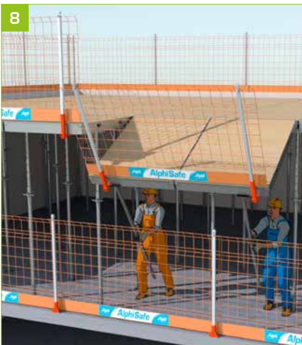
- Die Paneele mit den MaxiDalle-Stangen anheben.
