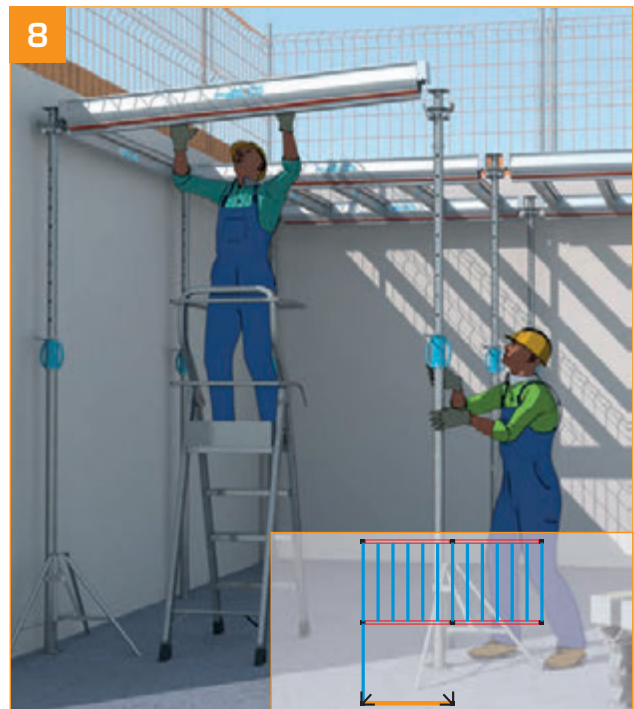
- Montar uma nova vigota primária num suporte técnico.
