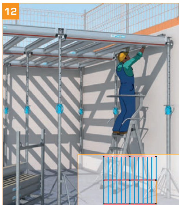
- Concluir a montagem das vigotas secundárias.
