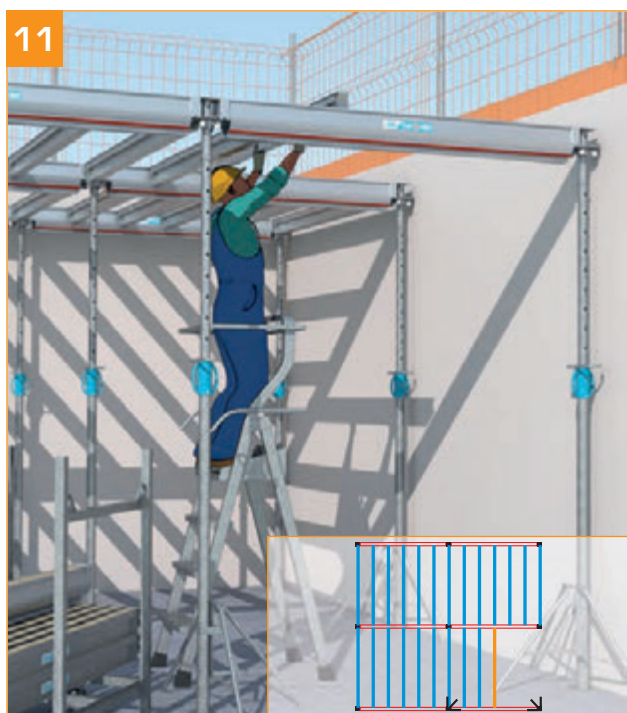
- Colocar as vigotas secundárias a passo e passo, respeitando o espaçamento de 39 cm.
