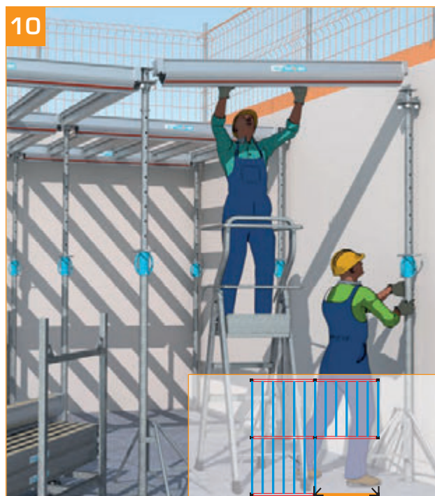
- Montar uma nova vigota primária num suporte técnico.
