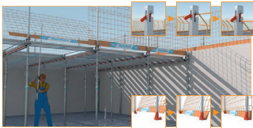
A rede é travada na parte superior pela cavilha antielevação e bloqueada na base por rotação.
