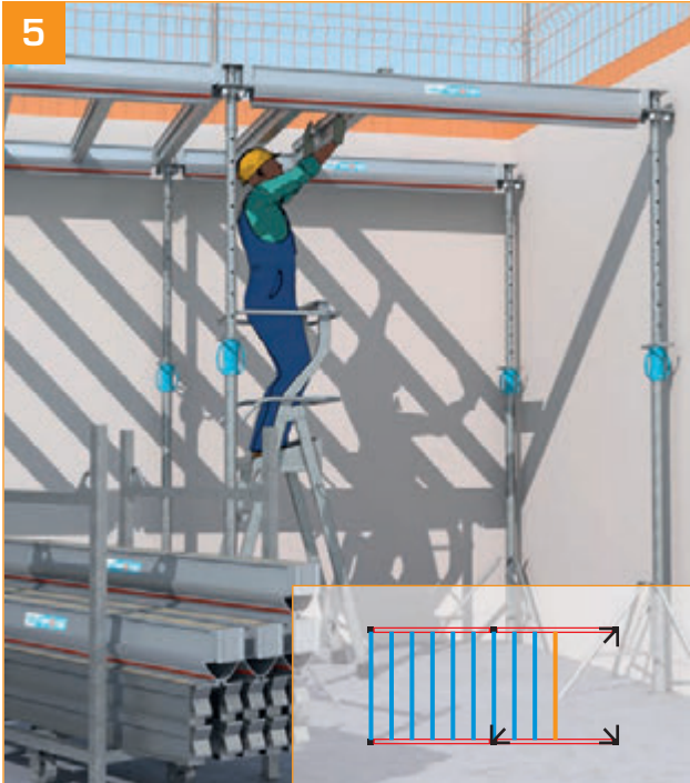
- Colocar as vigotas secundárias a passo e passo.
