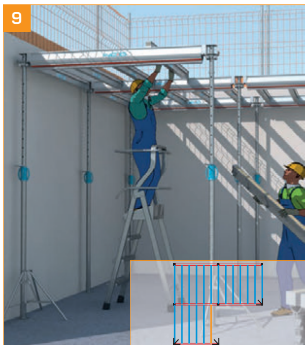
- Colocar as vigotas secundárias a passo e passo.
