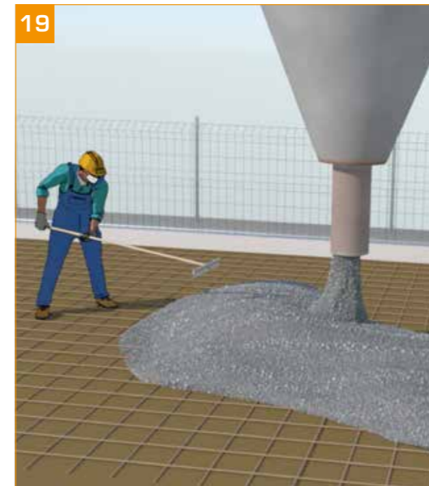
- Execução da laje de betão, após a colocação da armadura e as misturas. → Espalhamento do betão sobre a cofragem, sem sobrecarga das vigotas e dos suportes técnicos.
