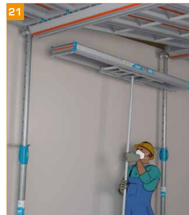
- Descofragem da laje: retirar os painéis Éco+, passo a passo, com a ajuda da vara TopPerche Éco...
