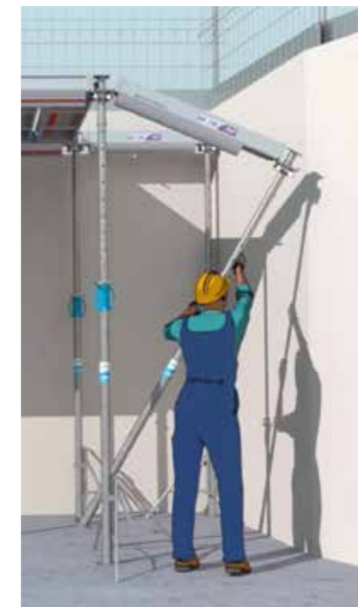
As vigotas extensíveis permitem a aproximação aos extremos de cada célula.
