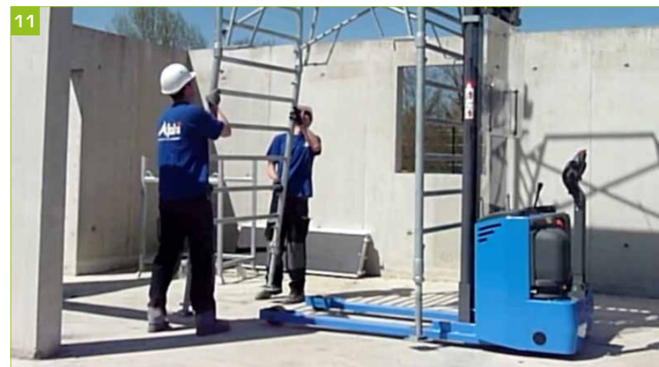
- Introduzir a segunda escada de 1,5 metros. - Juntar a escada à do nível superior, com a ajuda de pernos.
