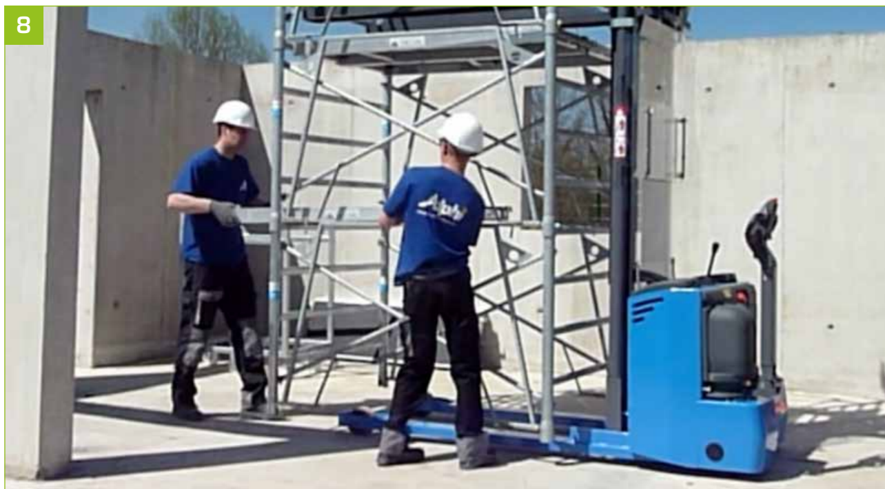
- Repetir as operações 4 a 7 até à altura pretendida.
