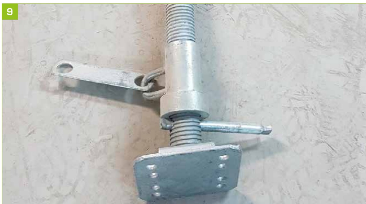
- Pré-regulação e montagem dos cilindros de pés em escadas de 1,5 metros.
