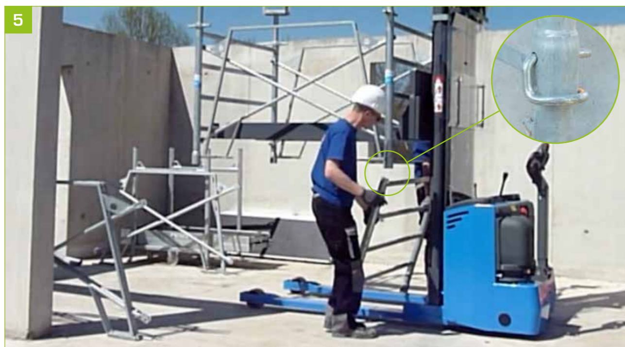
- Montar o segundo nível de escada debaixo do primeiro nível, com a ajuda de pernos. - Repetir a operação para a outra escada.
