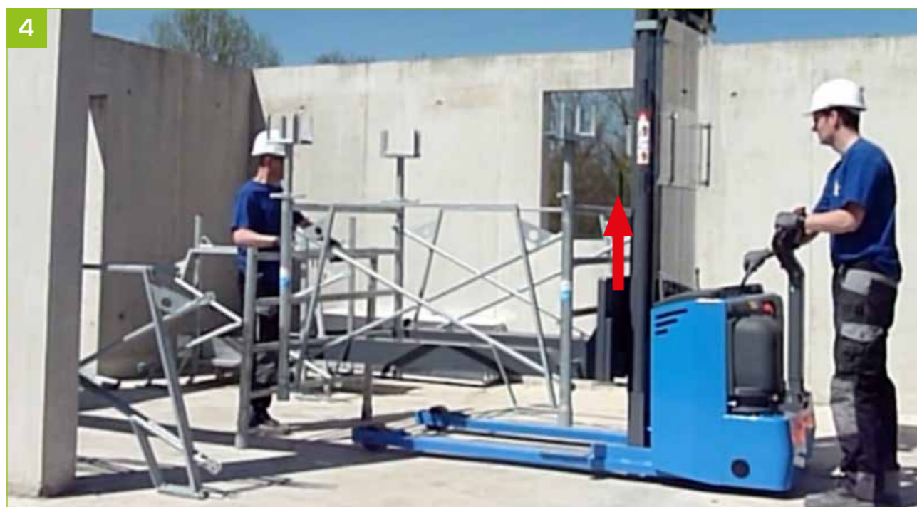
- Com a ajuda do Monte-Tour, levantar o primeiro nível, de modo a permitir deslizar uma segunda escada de 1 metro.
