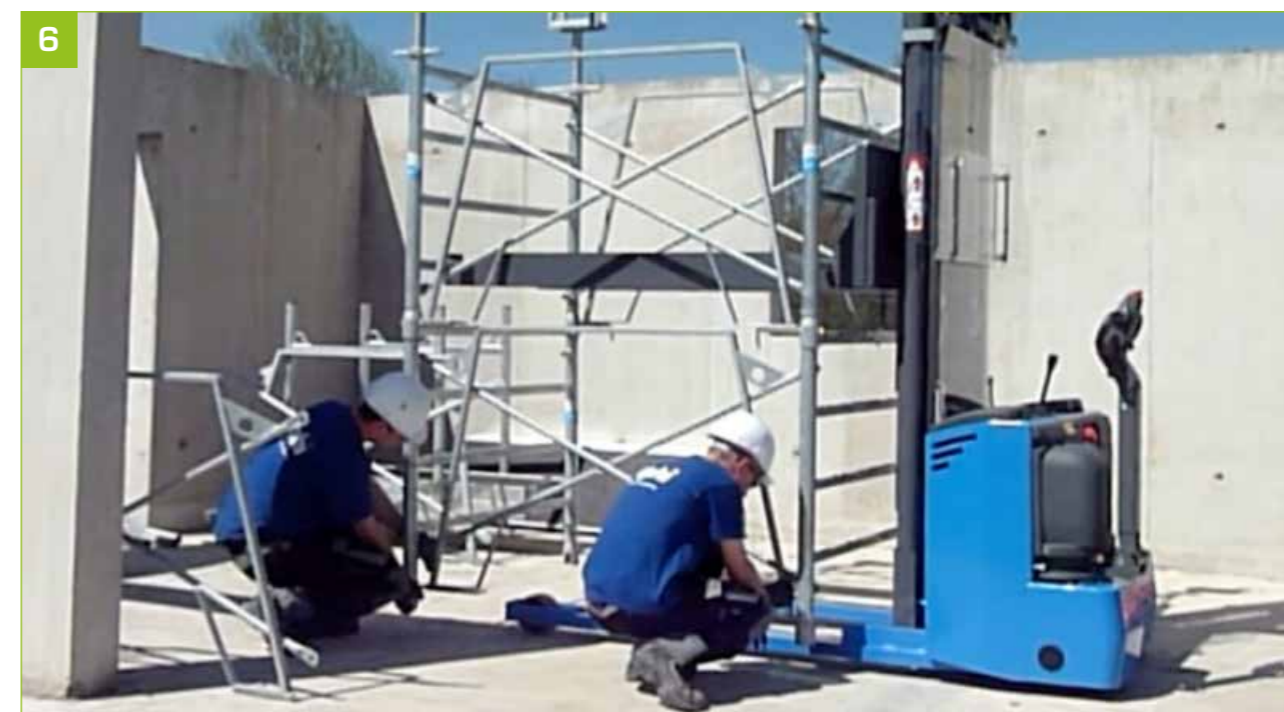
- Montar os guarda-corpos: garantir que os pinos basculantes (automáticos) ficam bem presos.
