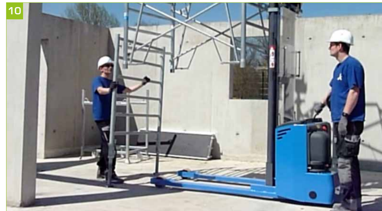
- Introduzir a primeira escada de 1,5 metros. - Juntar a escada à do nível superior, com a ajuda de pernos.
