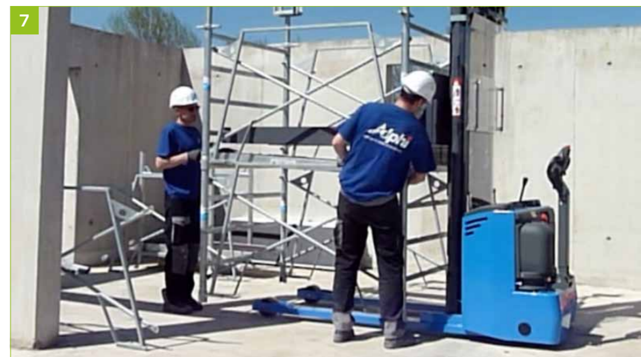
- Instalar as plataformas de trabalho na torre.
