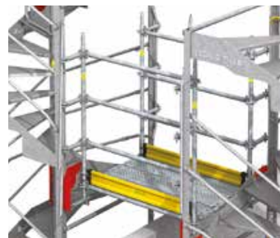
Steg oberhalb einer Gebäudewand
