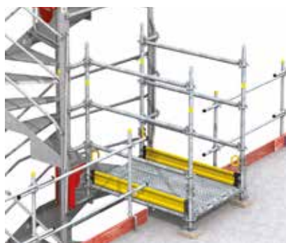
Arrivée sur dalle
