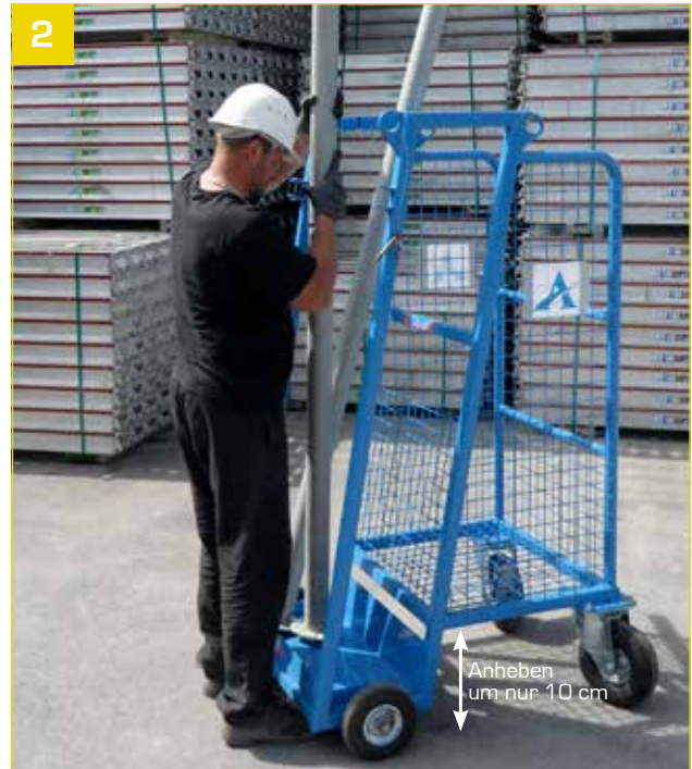
- Einsetzen der Stützen in das Transportgestell.
