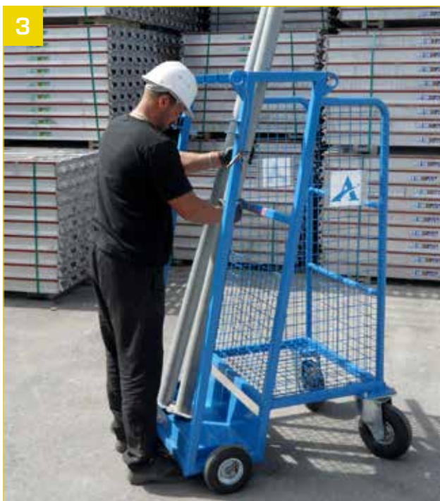
- Ausrichten der Stützen im Transportgestell.
