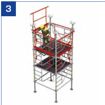
3 - Sicherer An- und Abbau von einer provisorischen Belagebene (Turmhöhe ≤ 3 Rahmen).
