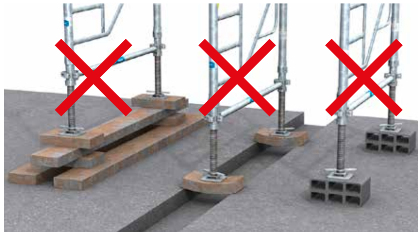
Zu hoch gestapelte, lastverteilende Unterlage
