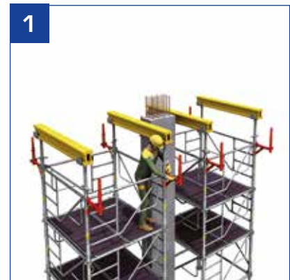
- Der Aufbau der Belagebene wird in kollektiven Sicherheit von einer provisorischen Belagebene aus durchgeführt.
