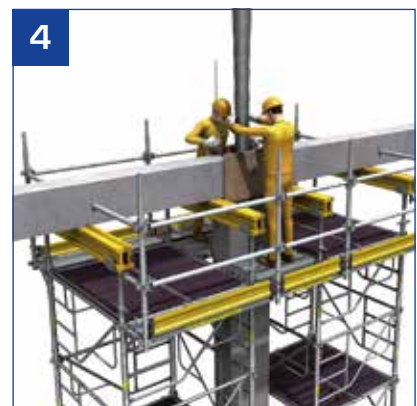
- Der Aufbau der Belagebene wird in kollektiven Sicherheit von einer provisorischen Belagebene aus durchgeführt.
