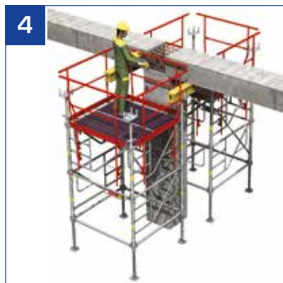
4 - Einsetzen der Betonträger: Sicherheitsgeländer in oberer Stellung.
