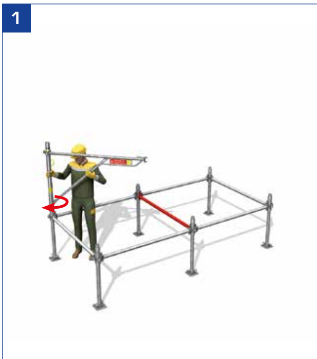
- Implantation et mise à niveau. Depuis l'intérieur de la tour, pose du 1 er cadre d'entrée dans l'axe de la diagonale puis rotation pour le verrouiller.
