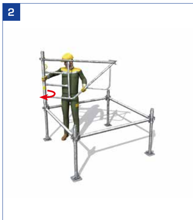
- Depuis l'intérieur de la tour, pose du 1 er cadre dans l'axe de la diagonale puis rotation pour le verrouiller.
