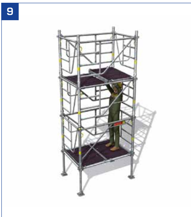
- Déplacement du 2 e plancher à trappe depuis le niveau inférieur.
