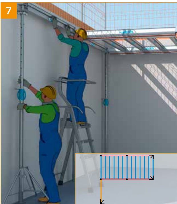
- Mithilfe einer weiteren Stütze einen neuen Nebenträger installieren.
