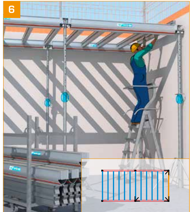
- Alle Nebenträger für diesen Abschnitt installieren.
