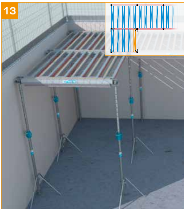
- Mit der Installation der Nebenrahmen C2+ oder C4+ fortfahren.
