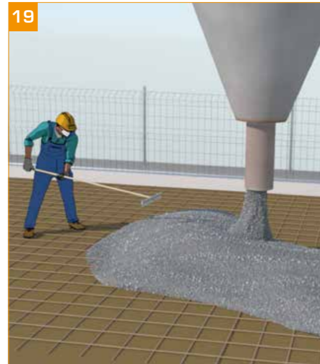
- Execução da laje de betão, após a colocação da armadura e as misturas. → Espalhamento do betão sobre a cofragem, sem sobrecarga das vigotas e dos suportes técnicos.
