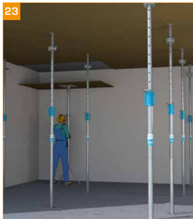
23 - Descer o suporte para placas até meia altura. - Retirar a placa de contraplacado.
