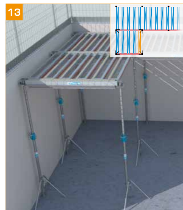
- Retomar a montagem das pranchas secundárias C2+ ou C4+.
