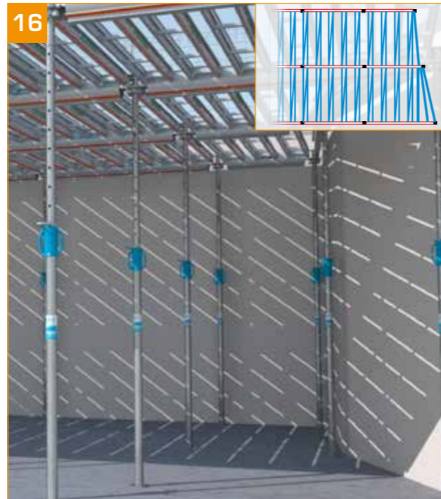
- Afinar o nivelamento por meio de um nível de laser, suporte a suporte. - Uma bitola suspensa da cofragem permite que um único homem efetue a regulação com o nível de laser. - Nesta etapa, efetuar uma verificação final do bloqueio dos cabeços.
