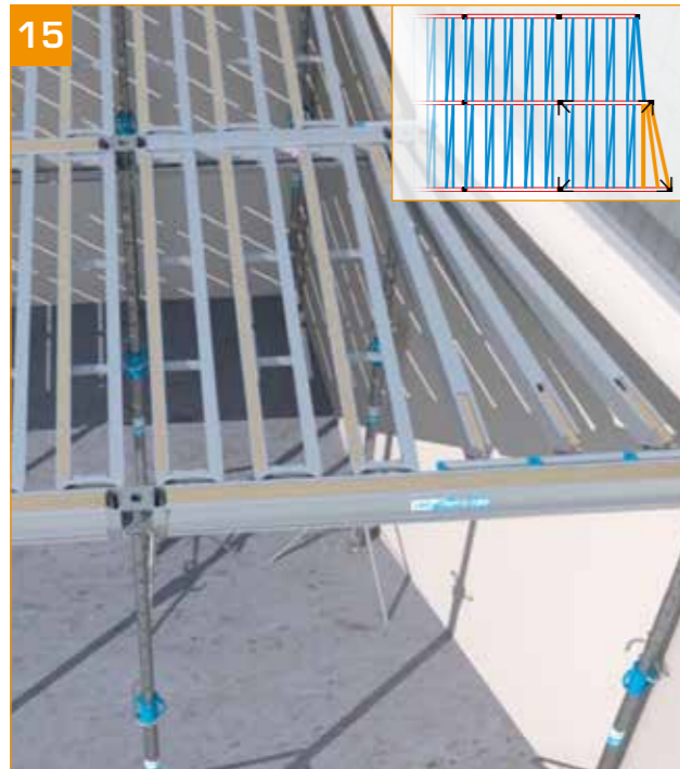
- Repetir a etapa 6 e concluir a montagem das pranchas secundárias C2+ ou C4+.
