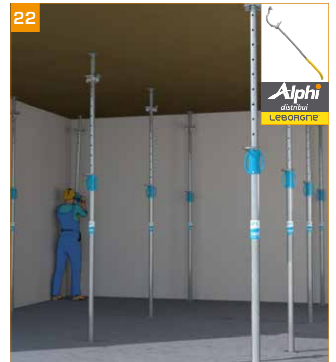
- Descofragem da laje: retirar os suportes técnicos colocados na periferia das células. - Deixar no local, pelo menos durante 3 dias , os outros suportes técnicos (em função do tipo de betão e da temperatura ambiente).
