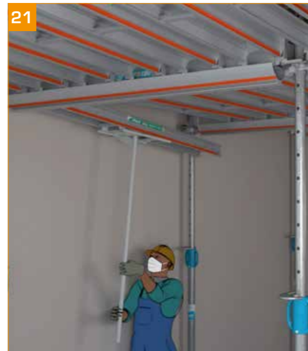
- Descofragem da laje: retirar as pranchas C2+ por fases e, em último lugar, as vigotas primárias com a ajuda da vara TopPerche. - Arrumá-las nos suportes de rodízios.
